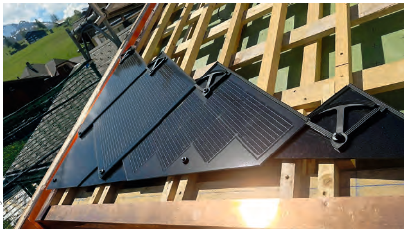
Im Zuge der Dachsanierung der katholischen Kirche St. Franziskus in Zweisimmen wird das Kirchendach mit Photovoltaik-Dachschindeln eingedeckt.
